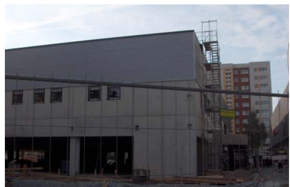
Hauptstraße 10, Berlin-Hohenschönhausen Neubau eines Verbrauchermarktes mit offener Garage Baubeginn: 14.04.2011 Rohbaufertigstellung: 13.09.2011
