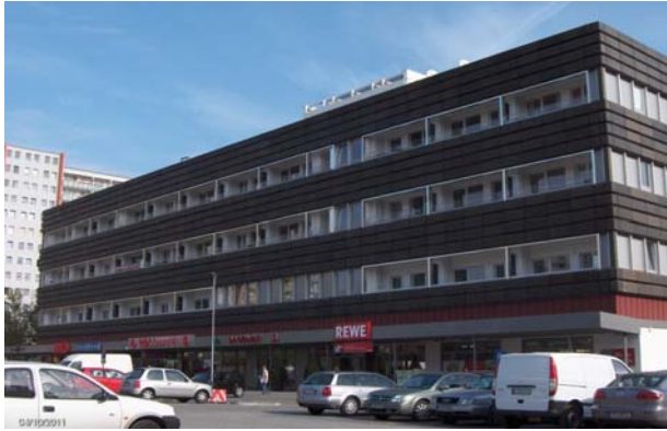
Anton-Saefkow-Platz 8, Berlin-Lichtenberg Umbau und Nutzungsänderung des 2. und 3. Obergeschosses von Warenhaus zu Wohnungen Baubeginn: 24.01.2011 Abnahme: 16.08.2011
