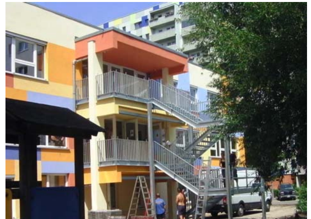
Charlottenstraße 3 Sanierung der Kita „Märcheninsel“ Fertigstellung: 17.08.2011
