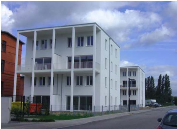
Georg-Löwenstein-Straße (FS 213, 216) Neubau zweier Stadtvillen Fertigstellung: 15.09.2011
