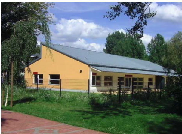
Gensinger Str. 56A Neubau einer Jugendfreizeiteinrichtung Fertigstellung: 01.09.2011
